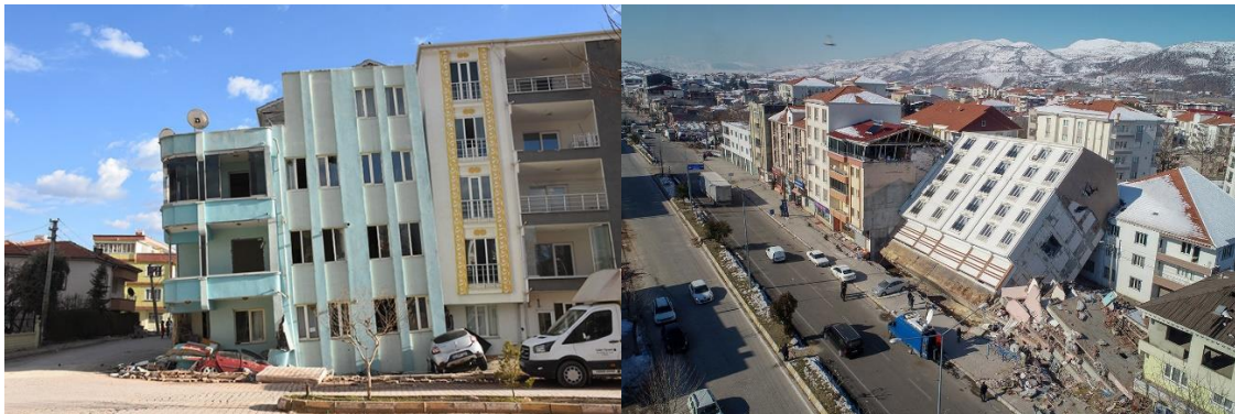
Şekil 33. Zemin sıvılaşması nedeniyle hasar almış binalar (TMMOB, 2023)
