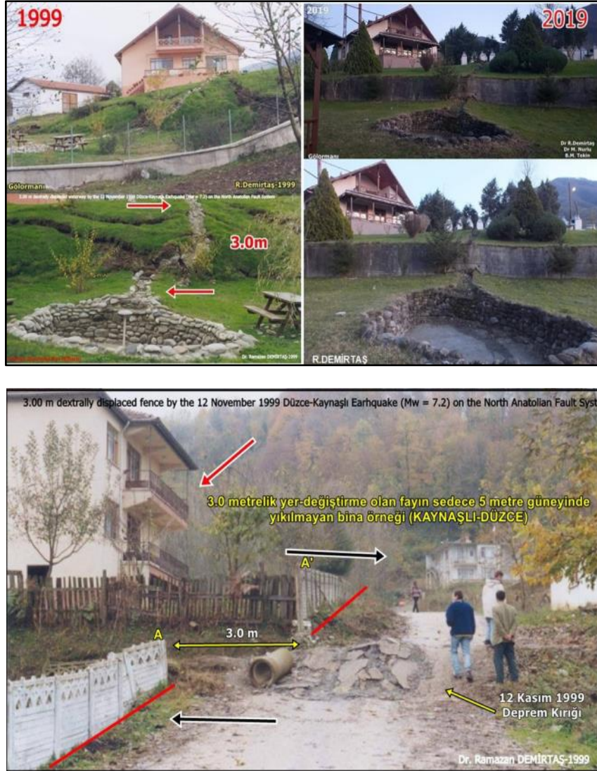
řekil 5. 12 Kasım 1999 Düzce-Kaynařlı depremi yüzey faylanması yakınında yıkılmayan konutlar (Demirtař, 2023)
