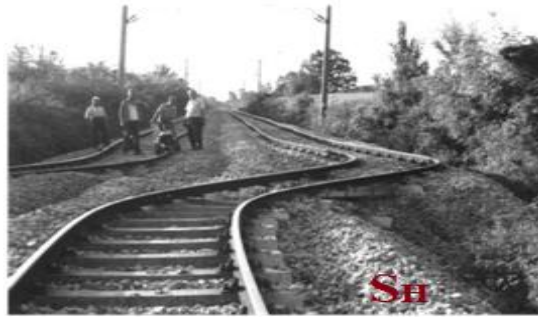
Şekil 3. a) Yayılma doğrultusunda yatay titreşen kayma dalgası S_H bileşeni, b) S_H bileşeninin oluşturduğu zemin deformasyonu örneği.
