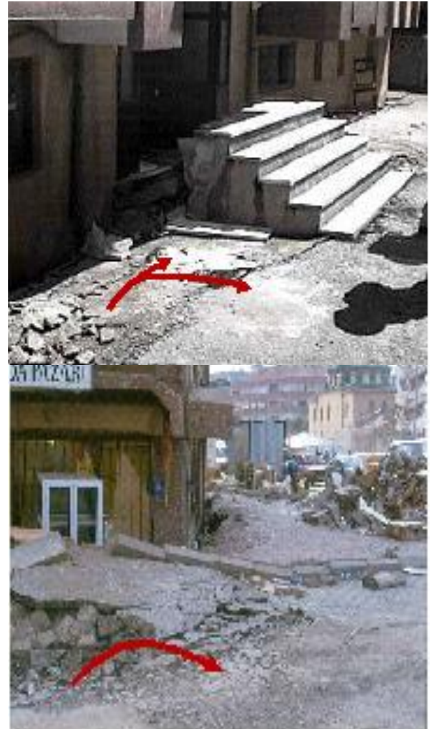
Şekil 1. Zemin sıvılaşması örneği.
