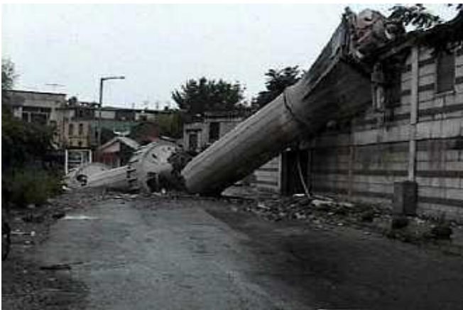
Şekil 2. Minare devrilmiş ve kırılmış ve cami yan yatarak yıkılmış. Fig.2. The minaret and mosque side lying overturned and broken destroyed.
