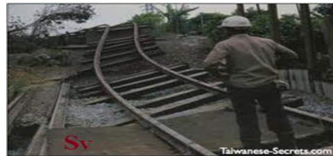
Şekil 4. a) Yayılma doğrultusuna dik titreşen kayma dalgası S_V bileşeni, b) S_V bileşenin oluşturduğu zemin deformasyonu örneği..
