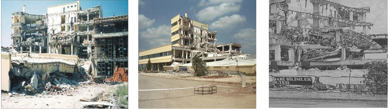
Şekil 3. Kocaeli üniversitesi Aslanbey Kampüsü İdari Bilimler Fakültesi binası 1999 deprem hasarı Fig. 3. 1999 earthquake building damage in Arslanbey Campus Faculty of Administrative Sciences
