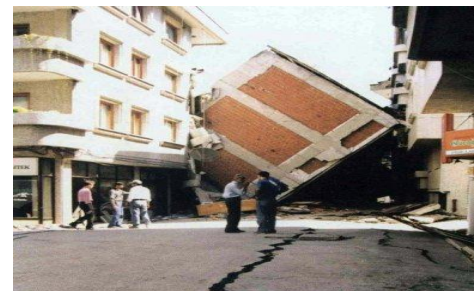
Şekil 5. S_H kayma dalgası zemin deformasyonunun sebep olduğu deprem hasar örneği.
