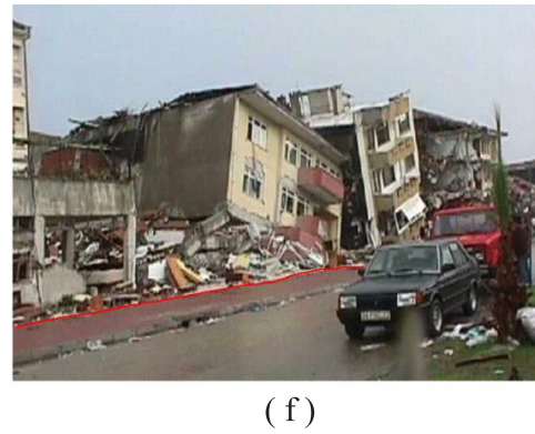
Şekil 6. S_v kayma dalgası zemin deformasyonunun sebep olduğu deprem hasar örnekleri. Fig. 6. Examples of earthquake damage caused by S_v shear wave soil deformation.
